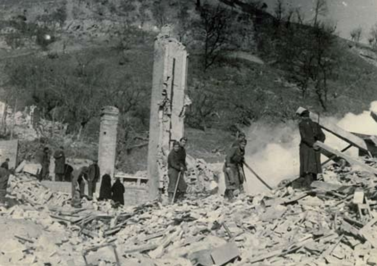
22 gennaio 1944. Montecchio di Sant'Angelo in Lizzola - Pesaro. Scoppio di un deposito di mine. Ciò che rimane della casa sede della succursale della Banca Popolare Pesarese e di alcuni uffici del Comando tedesco
